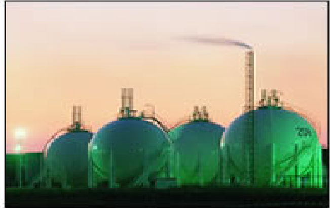
Du transport au stockage
