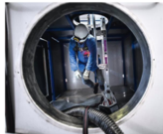
Intervention en espace confiné
