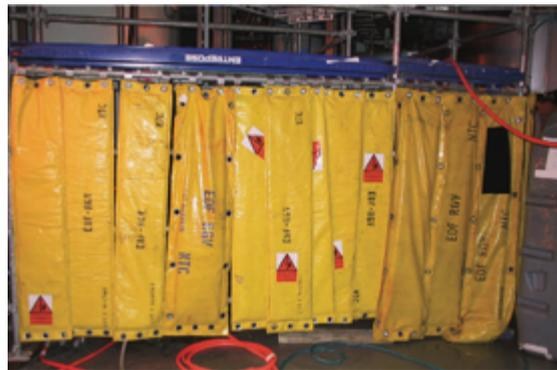
Photo 5: Matelas de plomb. Source : Memento de la radioprotection (EDF).
