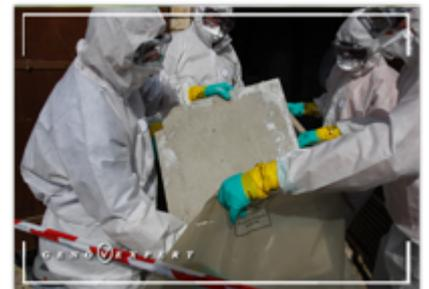
Photo 14: Mise en sac d'un matériel amiante. Source : Genovexpert.fr.
