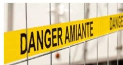
Photo 12: Exemples de balisage "risque amiante" et étiquetage de la zone. Source : desamiantage-idf.com.
