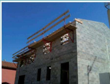
La console est un échafaudage d'un type particulier assujéti à la réglementation traitant des échafaudages. Entre autre, les matériaux qui les composent doivent être de même nature et les consoles « maison » ou échafaudages constitués d'éléments en bois sont **INTERDITS** (voir R 4323-70 à R 4323-79 du Code du travail). Enfin, sa mise en oeuvre doit respecter les dispositions prévues dans la notice du fabricant.
